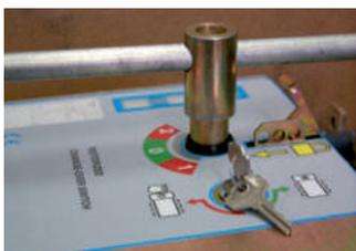
Рукоятка для ручного действия со скользящим захватом. Хранится около разъединителя.
